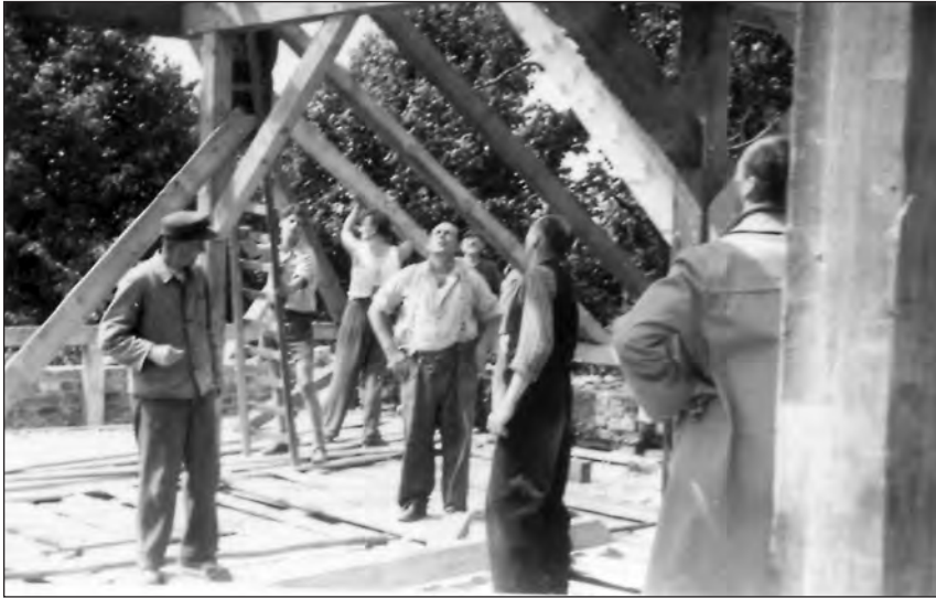
Errichtung des Dachstuhls. Rechts, halb verdeckt: Fritz Gudenschwager.
